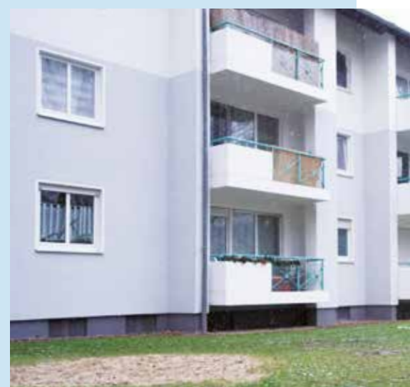
Das modernisierte Gebäude
